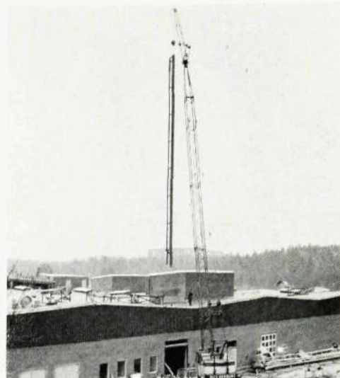
En av de två skorstenarna för panncentralen i Flemingsbergslagret lyfts elegant på plats av en större mobilkran. Skorstenarna skall senare isoleras och förses med aluminiumplåt. Från markplanet till skorstensändan är det 27 meter.
