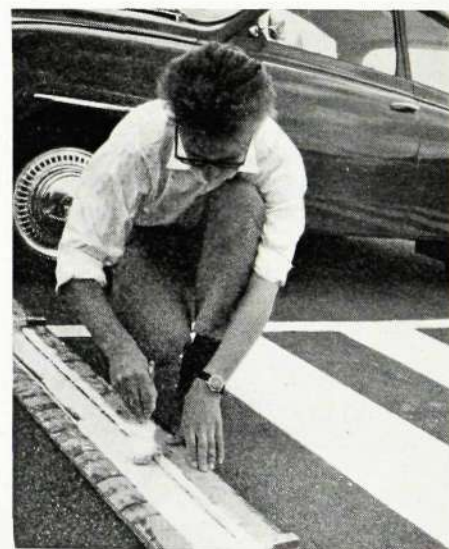
Vi gissar att tusentals ton vit färg går åt för högeromläggningen. Här målar vår man i Oskarshamn parkeringsplatsen utanför fabriken. Enbart där gick det åt över 40 kg vitfärg!
