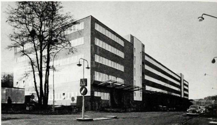
Det nya kontorshuset i Årstadal.
