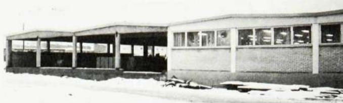
Olofströmsverkstaden ökas j. n. ut med 1 500 kvm. 1 maj planeras bygget stå klart och därmed blir OM:s totala golvyta 3 800 kvm.
