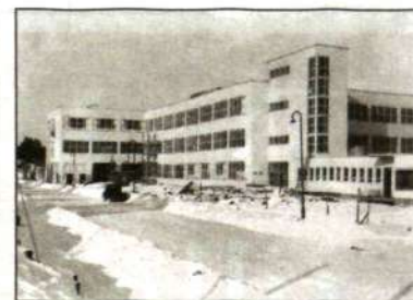
Så här såg Ericsson vid Telefonplan ut under bygget. Bilden är från 1938. De funktionalistiska dragen är tydliga.
