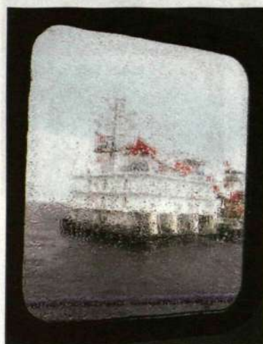
Ett kraftigt oväder över Siambukten försenade kabelprojektets förarbete i november. Vid gynnsamma förhållanden kan fartyget klara av att lägga ned 30 till 60 kilometer kabel per dag beroende på bottenförhållandena. Arbetet är även känsligt för kraftiga dyningar och mycket hänger på väderleken.
