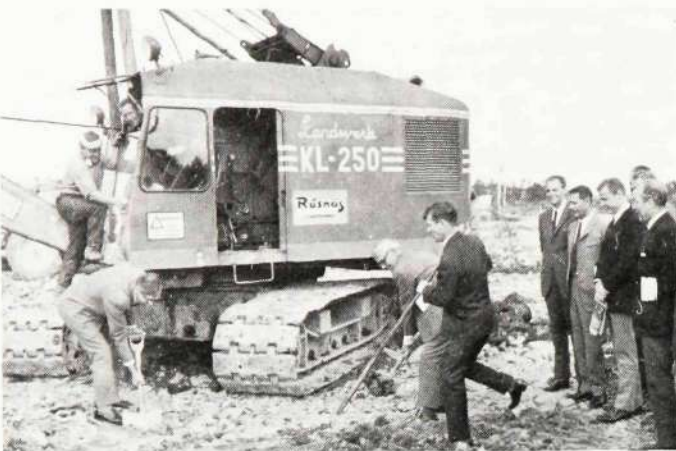
Byggstarten för det nya centrallagret. Per-Bertil Janson, LMS' VD, passade på att kliva upp i förarhytten till en grävskopa. Ivriga att hjälpa till var också fr.v. Olle Swartz, Erik Liselius och Sven Nyström.
