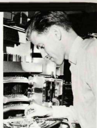
Provning av 500-väljaren i provpall utförs av Sören Thure, Vt 867.
