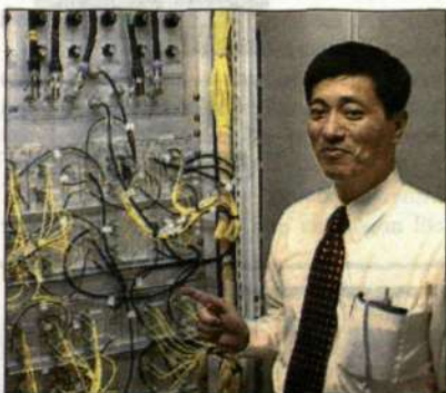
Masao Ito, produktchef på Ericssons japanska bolag NRJ, vid en Local Interface Unit, som omvandlar radiosignalen till en optisk signal som sen via optiska fibrer sänds ut till antenner som täcker mycket stora ytor.
