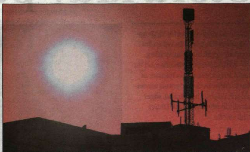
Från en radiobasstation sänds vågor ut i en riktad stråle. Det innebär att exponeringen vid marken är ytterst liten.
