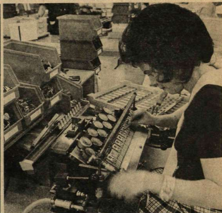
Montering och justering av reläer görs på Ingelstafabriken enligt "Norrköpingsmetoden", som bl a innebär att reläerna under alla tillverkningsmoment hanteras tio åt gången. Här justerar Mary Svensson slagvidden på en sådan tio-grupp.
