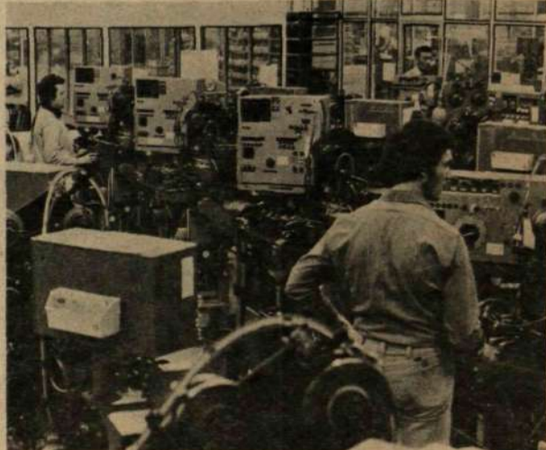
I det här rummet surrar tjugofem automatiska lindningsmaskiner för bl a Mini-print kondensatorer. Genom ljudabsorberande skivor i taket har man lyckats få ned bullret till acceptabel nivå.
