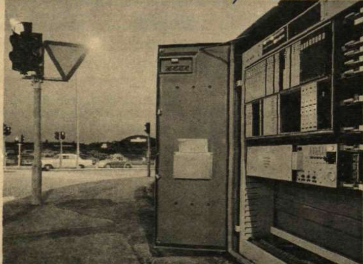
LME:s helelektroniska trafiksignalsystem har provats i den hårt trafikerade korsningen Bällstavägen—Solvallavägen i Sundbyberg.
