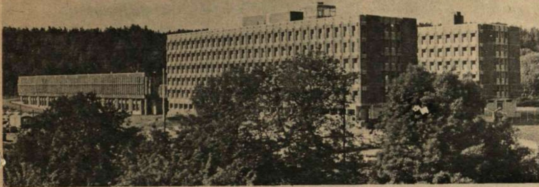
A/S Elektrisk Bureaus nya anläggning i Billingstad.
