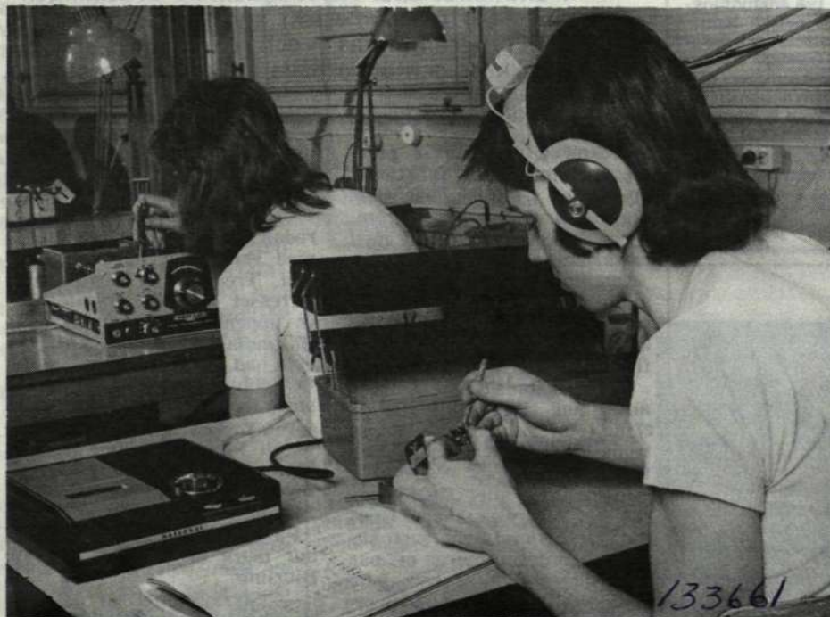
Elever vid Fredrika Bremerskolan i Handen intill Stockholm som går den 2-åriga tele-tekniska linjen inom gymnasieskolan lär sig här reläjustering med hjälp av tonbandsin-struktion.
