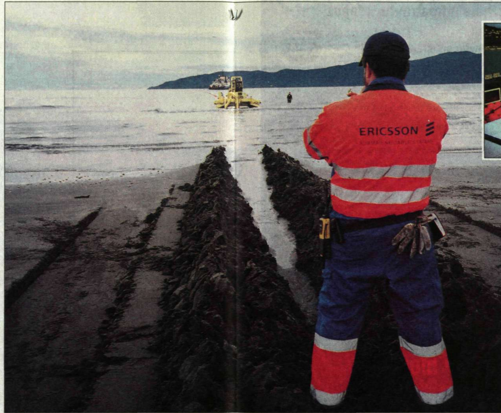
Ericssons marinspecialist Dan Kenealy övervakar plogen, som används för att gräva diken som kabeln sedan läggs ned i.
