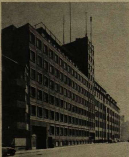
Från stadens larm och støj till det miljövänligare KISTA på Järvafältet flyttar SRA om fyra år. Fastigheterna vid Alströmmergatan (t h) — Industrigatan samt fabriken i Ulvsunda/Bromma (nedan) lämnas då för en samlad verksamhet i en ny industribyggnad. I dag står barrskogen tät med inslag av björk på KISTA-tomterna, som framgår av de härnäst tagna foto- na.
