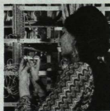
Harminder Rehal, född i Kenya, har under sina tolv englandsår mest jobbat på fabrik. I Mollison-installationen kopplar hon in mellankopplingslister och uppger sig trivas mycket bättre än på fabrik — här slutar ingen, är hennes slutkommentar.
