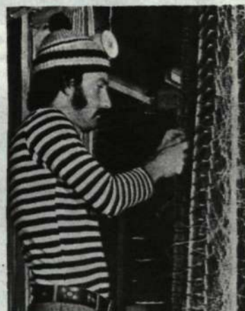
Personalen på Mollison House är mycket internationell — liksom för hela London. Här avmantlar Joseph John Sagina kabel för BDH-stativ. Joseph har jobbat med teleinstallationer i England i fem år och kommer ursprungligen från Gambia.
