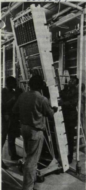
För materialhanteringen i Mollison-installationen används moderna hjälpmedel av olika slag. Här en hydraulisk lyftvagn med vilken stativ på upp till 300 kg kan transporteras fram och lyftas upp på sin plats i stativraden. Hanteringen blir dessutom skonsammare och man får mindre justerings- och provningsarbete.
