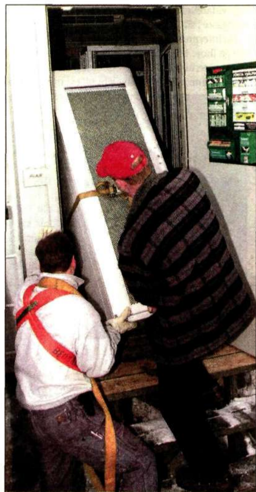
Ännu en av de drygt 10 000 basstationer som ska tjäna Svenska UMTS Nät, installeras på ett hustak i Stockholm.
