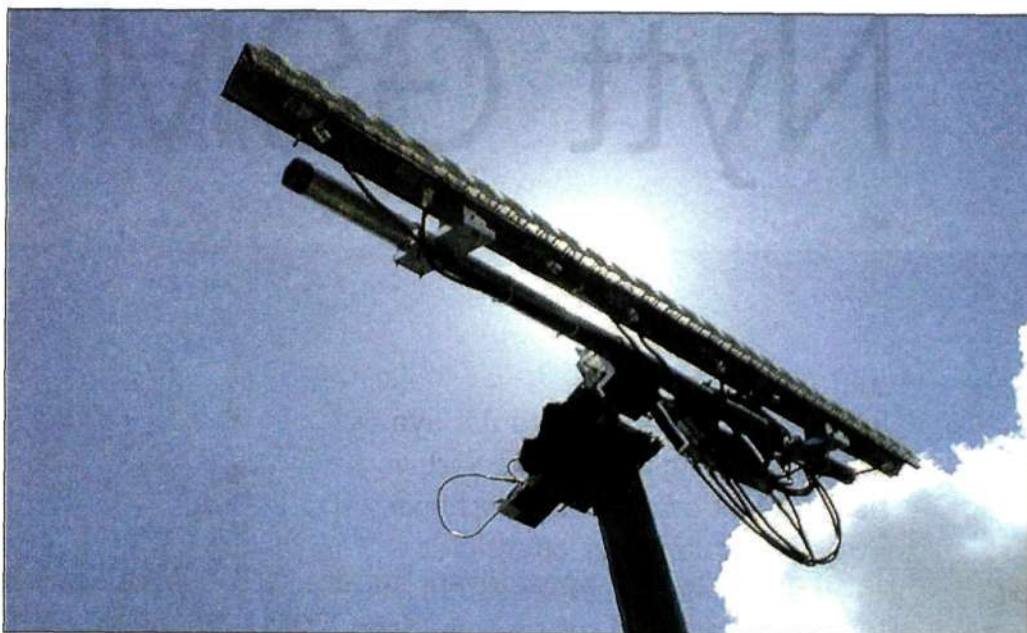
Ericssons 3G-antenn Jass som den ser ut under verifieringsfasen. I vanlig drift sitter den horisontellt och har ett hölje.
