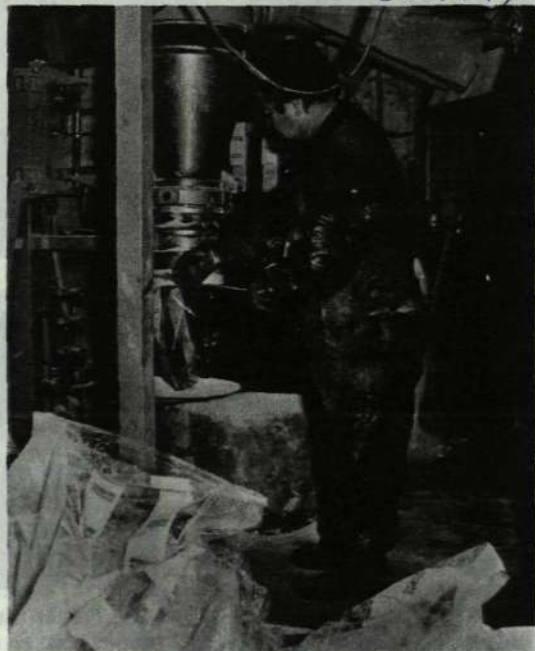
Sven Andersson på SKV/Vt 29 vid den automatiska doseringsanläggningen. Kemikalierna fylls i rätta mängder direkt i de genomskinliga påsarna.
