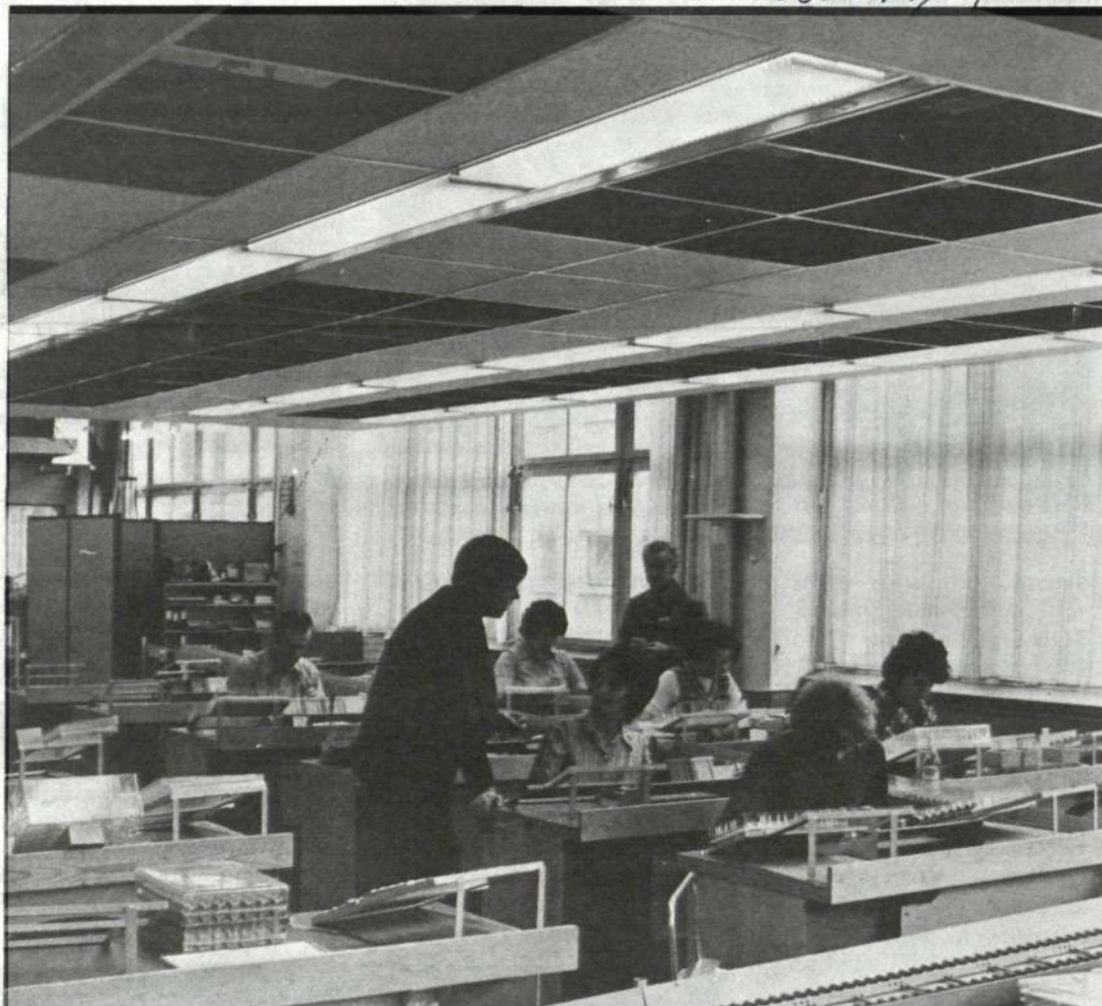
På Vt 39 har ett undertak byggts med asymmetrisk armatur, vilket ger ett riktat ljus på ca 600 lux i arbetsplanet. Verkmästare Gösta Olsson: — Att få en både trivsamt och
