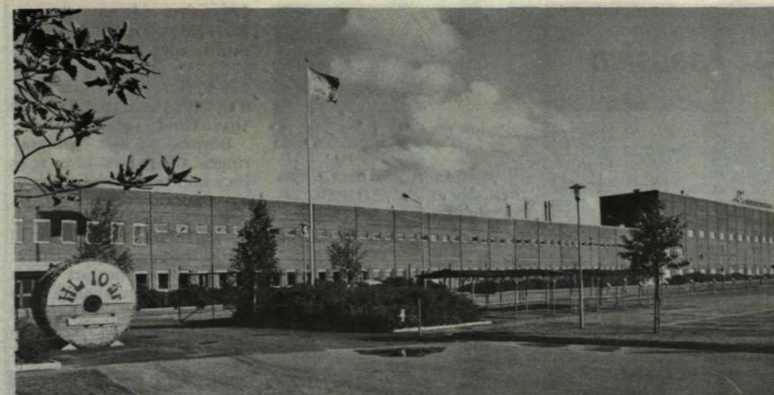
Hudiksvallsfabriken tidigt på morgonen innan regnet kom. Entrén ligger bakom kabeltrumman med texten "HL 10 år". Fabriken har en magnifik produktionshall på fem skepp och en totalyta på imponerande 37 500 m 2 utan mellanväggar. Förmöjligen LME:s största "rum".
