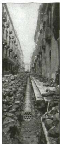
Gatuarbete med kablar i italienska Catania 1925.
