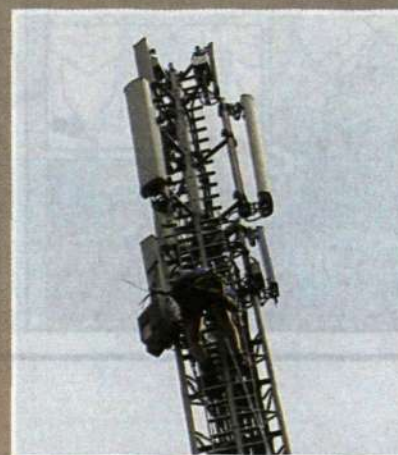
Mobilkom i Österrike har som första operatör i världen installerat Ericssons nya WCDMA-basstation RBS 3402 i sitt nät. Den nya basstationen gör det lättare för en kund att snabbt få mobil täckning i exempelvis stadsmiljö.
