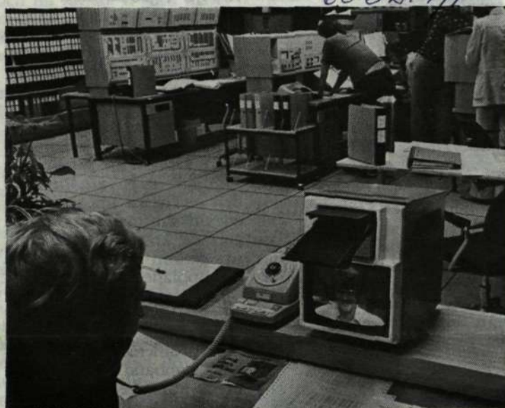
Under installationen och idriftsättningen i Hammarby har man haft god nytta av en bildtelefon i stationens kontrollrum för att exempelvis komma i kontakt med Tellusanläggningen och Lars Magnus Eriksson (ja, inte gamle LM förstås) på systemprovningen för AKE-stationer.
