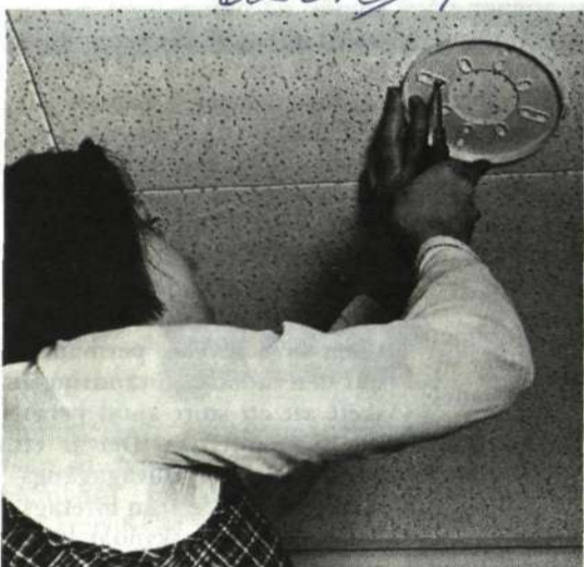
Det är enkelt att montera SEFYR. Tag bort fästplattan och använd den som mall för att märka två skruvhål. Borra hål för skruvarna och skruva fast plattan. Avstånd till närmaste vägg: Minst 50 cm.
