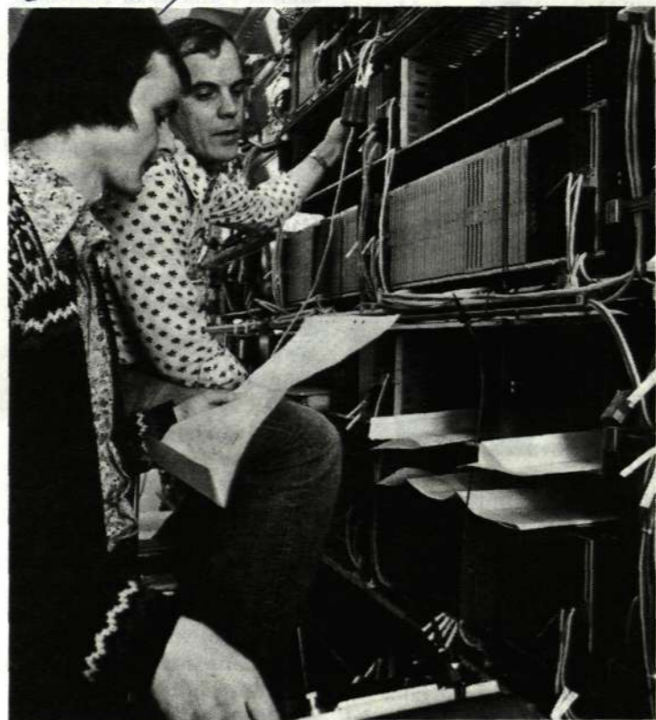
Så här ser det ut bland stativraderna på AXE-stationen i Södertälje under drift. Kraven på utrymme är blygsamma tack vare den kompakta elektroniken — som en tumregel anges att 12 000 linjer kräver ca 100 m 2 golvyta.
