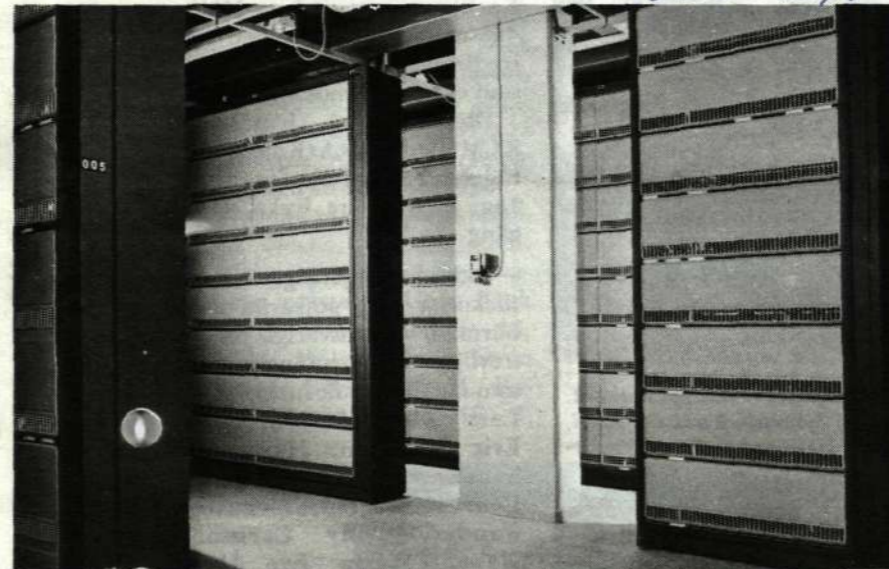
Så här ser det ut bland stativraderna på AXE-stationen i Södertälje under drift. Kraven på utrymme är blygsamma tack vare den kompakta elektroniken — som en tumregel anges att 12 000 linjer kräver ca 100 m 2 golvyta.
