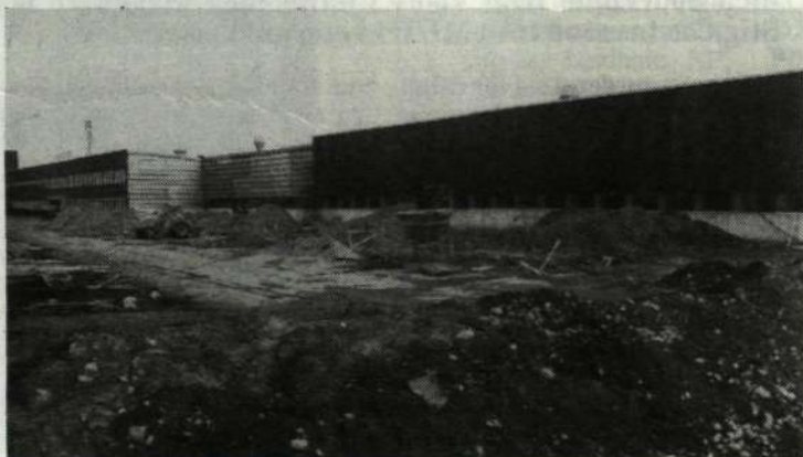
Nu schaktas för en välkommen utbyggnad av SKV:s Piteåfabrik.
