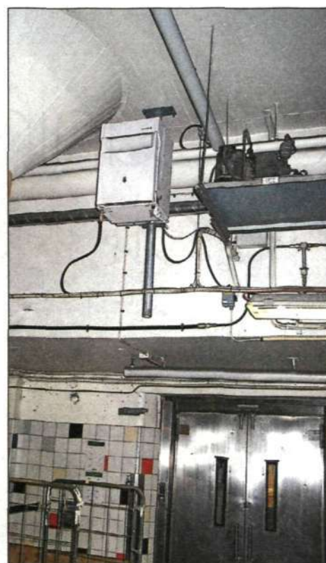
För att ge bra täckning åt saluhallen i centrala Stockholm satte man upp en mikrobasstation i parkeringsgaraget vägg i vägg med hallen. Därifrån drogs kabel till två antenner inne i hallen.
