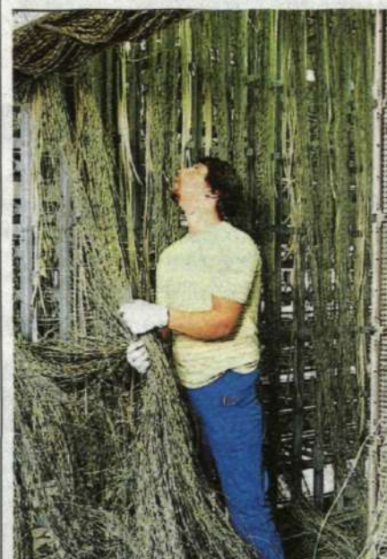
Kabelarbete i en telefonstation på 1970-talet.
