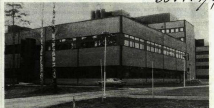
Tellusfabriken vid Kungens Kurva. Den främre husdelen inrymmer verkstadslokaler, den bakre är kontor.
