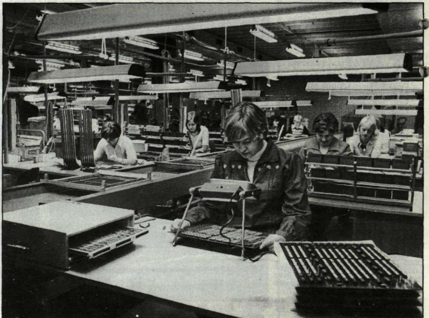
Fabriken i Älvsjö har en komplett mönsterkortfabrik och man monterar kretskort. Vidare finns en omfattande provning.
