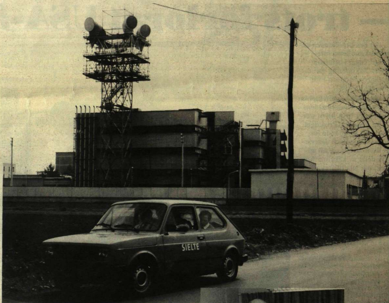
En av SIELTES servicebilar framför Syditaliens största telefonstation i Nola utanför Neapel. Här har SIELTE gjort stora installationer av långdistansnät. Foto: Thord Andersson
