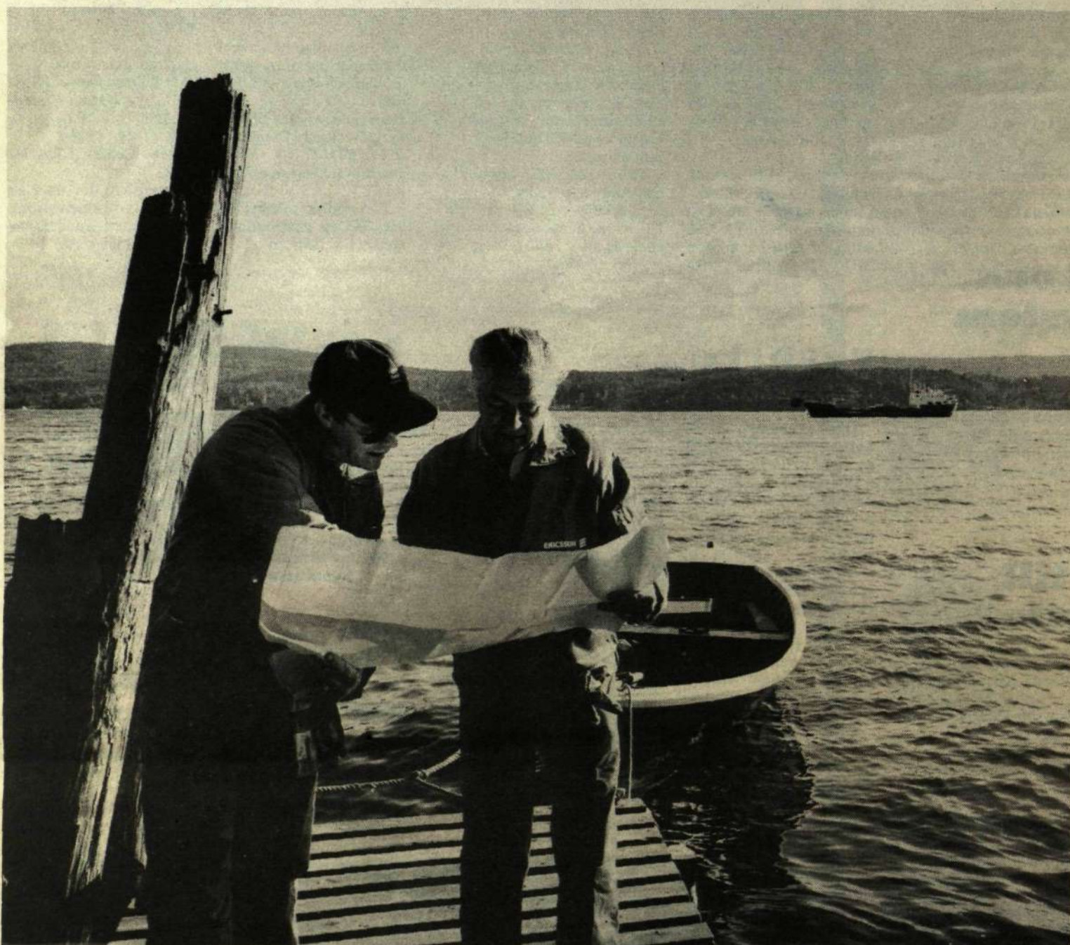
Projektledaren Erik Löfstedt, ENS, och Televerkets kontrollant Jan Åke Amnell (t v) konfererar över sjökortet hur kabeln skall läggas. Vid det här stället är Ångermanälven nära två kilometer bred. I bakgrunden syns Televerkets kabellägningsfartyg M/S Wartena. Foto: PETER STEEN
