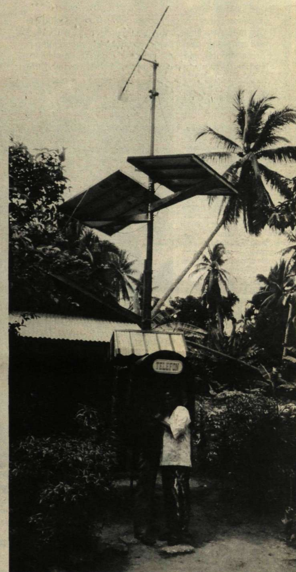
I länder där kabeldragning är komplicerad på grund av svår terräng har Ericssons cellulära radioteknik fått ökad betydelse för utbyggnad av de fasta telenäten. I Malaysia har många landsbyar fått sina första teleförbindelser med denna teknik, levererad av Ericsson.
