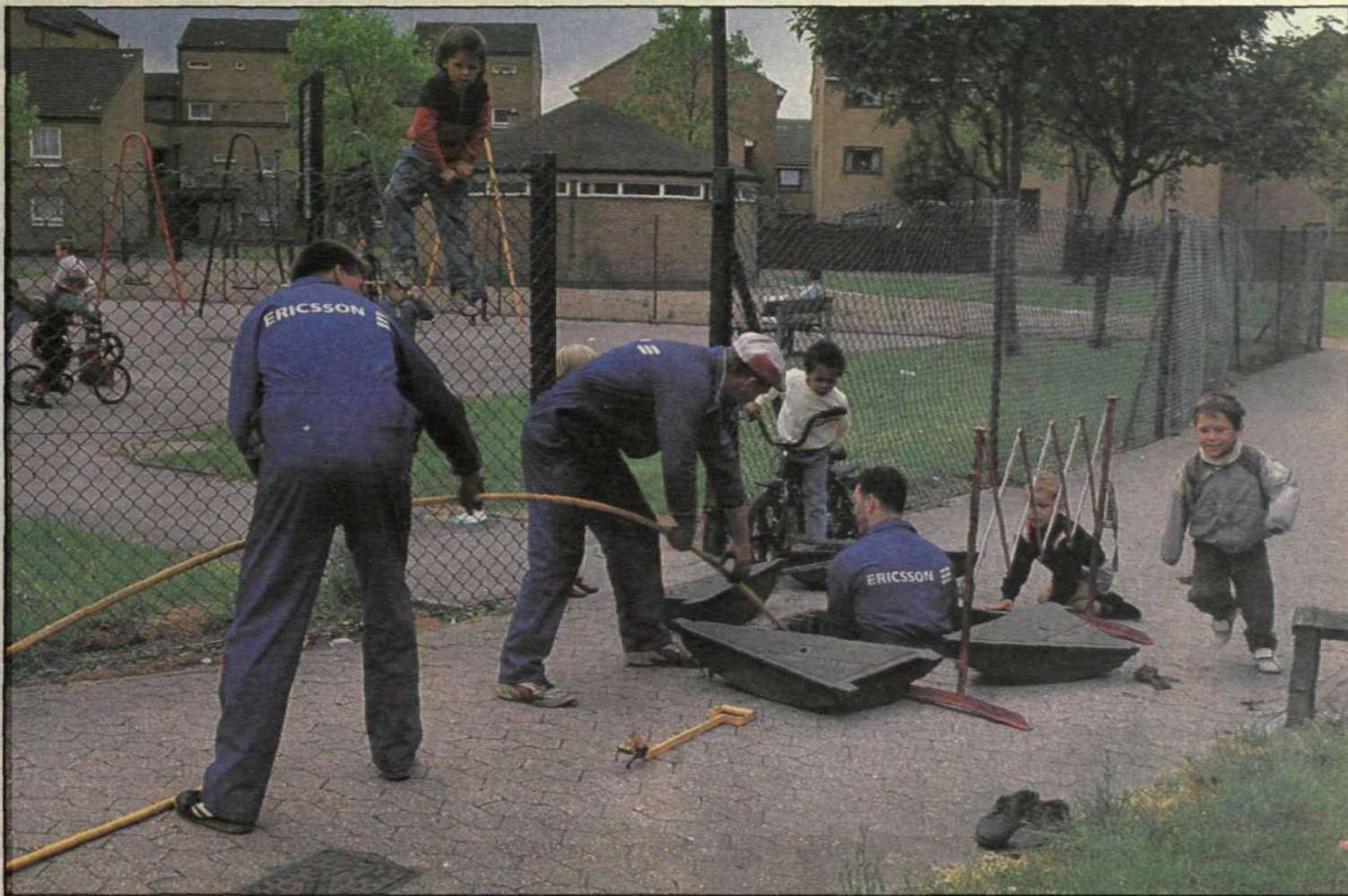
Kabelläggning inne i ett bostadsområde i centrala Nottingham.
