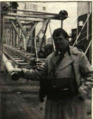
I oktober monterade Ericsson Data Services upp radiolänkmasten vid Globen. Den kommer att förse svenska folket med snabba tidningsnyheter. Här ses Örjan Sahlin från EDS vid monteringen.
