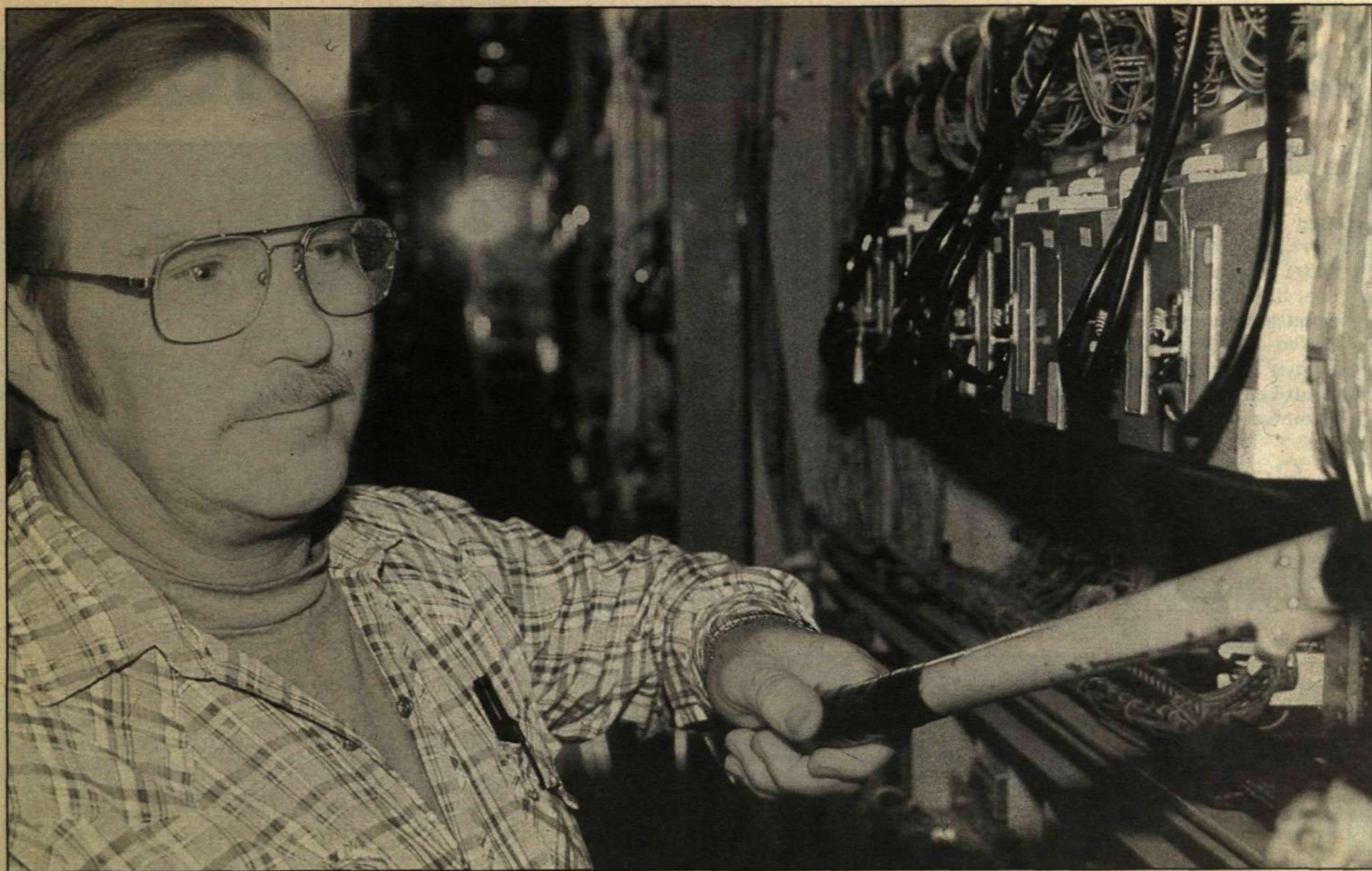
Den 14 november 1987 klippte Ericsson till kraftigt och gav en förning om vad som senare skulle komma. Här kapas de gamla kablarna i stationen i Canon City i Colorado när Ericssons första amerikanska AXE-station just gått i drift. FOTO I USA: ALF ÖST
