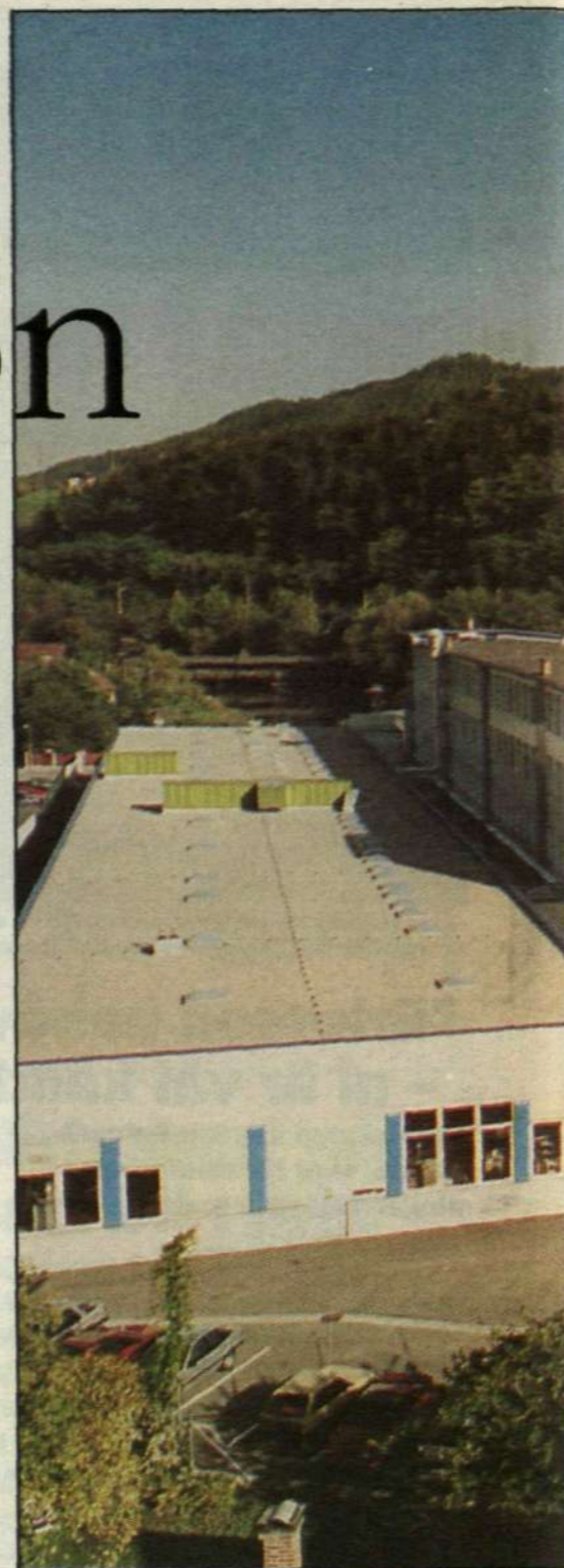
Schracks fabrik i Kindberg är en ombyggd
