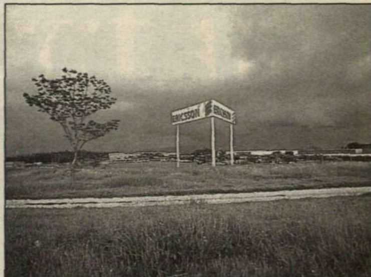
Ericsson i Brasilien – med fabrik i São José dos Campos – står bakom ordern till Companhia Paulista de Força e Luz i den brasilianska delstaten São Paulo. Foto: Lars Åström
