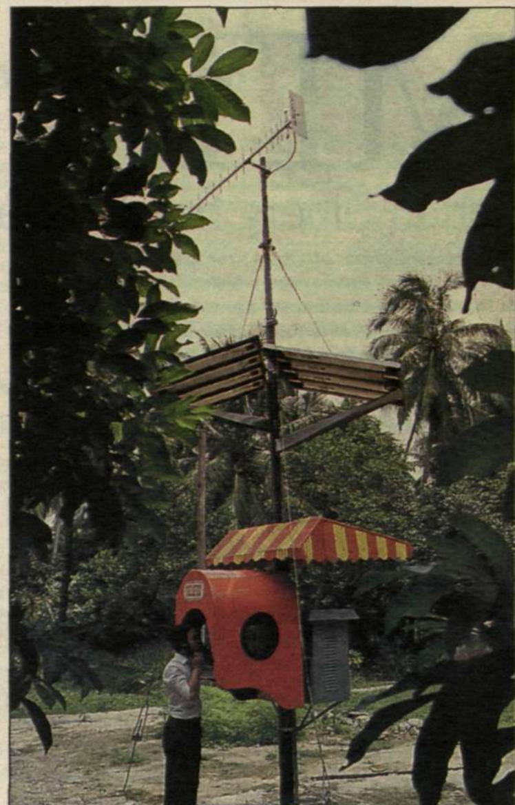
Ericsson har levererat radioteknik till Malaysia i många år. Ett annorlunda inslag är telefonkiosker i avlägsna byar som knyts till fasta nätet via radiolänk.
