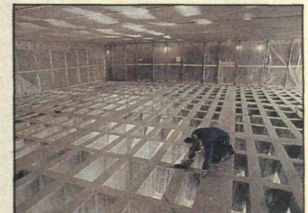
Supportplanet med pelarna som bär upp renrummet väffelgolvet. Här finns distributionsystemet för mela, luft, el, gaser, kemikalier från intilliggande rum. Golvet i supportplanet är separerat från pelare och väggar och bärs av en meter specialgrus som dämpar vibrationerna till och från berggrunden.
