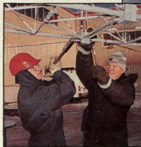
Bengt-Åke Nilsson och Björn Aronsson kontrollrar med hand alla muttrar på masten innan den går till väders.
