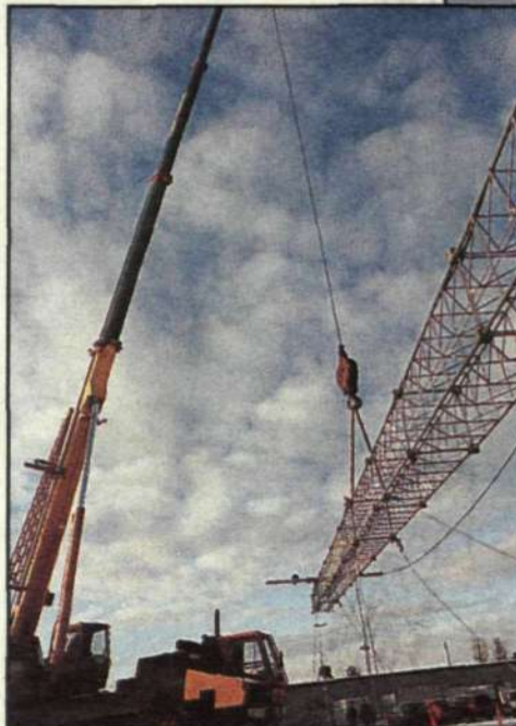
Nu här det i väg upp i skyn! Trots att masten är 51 meter hög, väger den bara drygt 1.500 kg.
