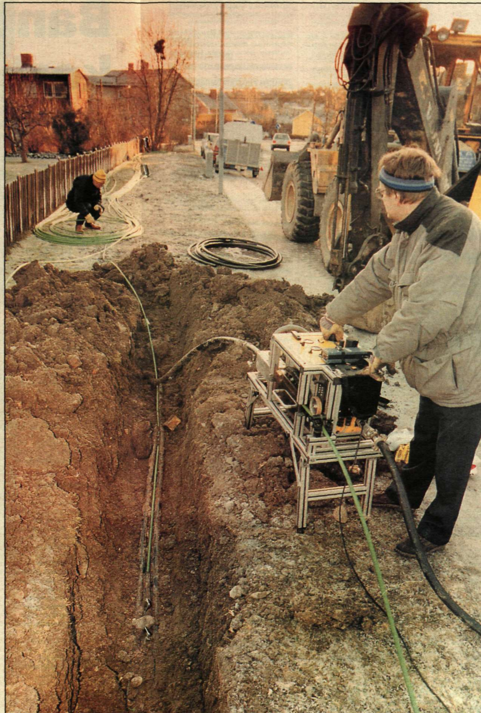
Tomas Falberg med den nya tryckluftsmaskinen från Lancier. Med åtta till tio kilos tryck blåser han in 96-fiberskabeln i röret någonstans bland villorna i Älvsjö. Foto: Konny Domnauer
