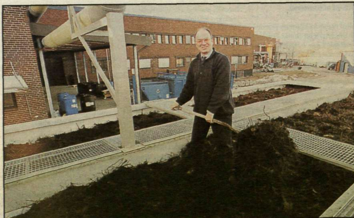
Mannen bakom den biologiska reningssystemet, Ulf Ljungberg, mitt i handlingens centrum. Här i det biologiska filtret, bestående av jord, torv och ljung, omvandlas lösningsmedlet till det ofarliga ämnet vatten och koldioxid.
