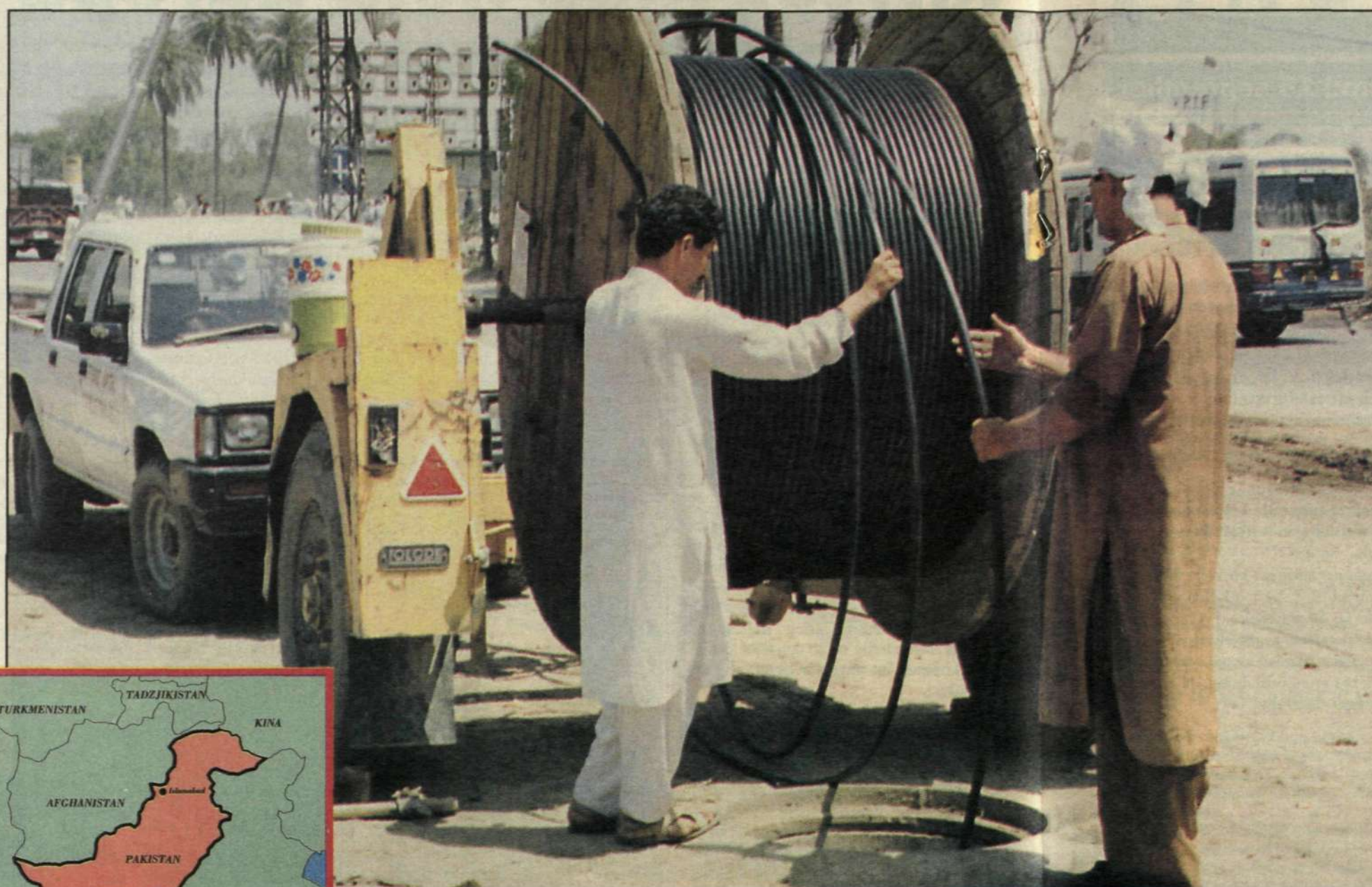
Här förläggs kabel från en av de över 4 000 kabeltrummar som gått åt under nätbyggnadsprojektet.
