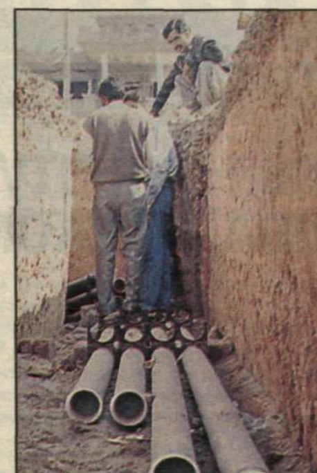
PVC-rör under förläggning. De djupa schaktet är till största del grävda för hand. Plats för expansion finns i nivån ovanför de nu lagda rören.
