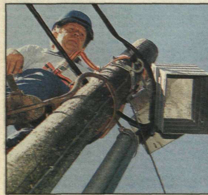
Hasse Rham i arbete med den luftburna kabeln.
