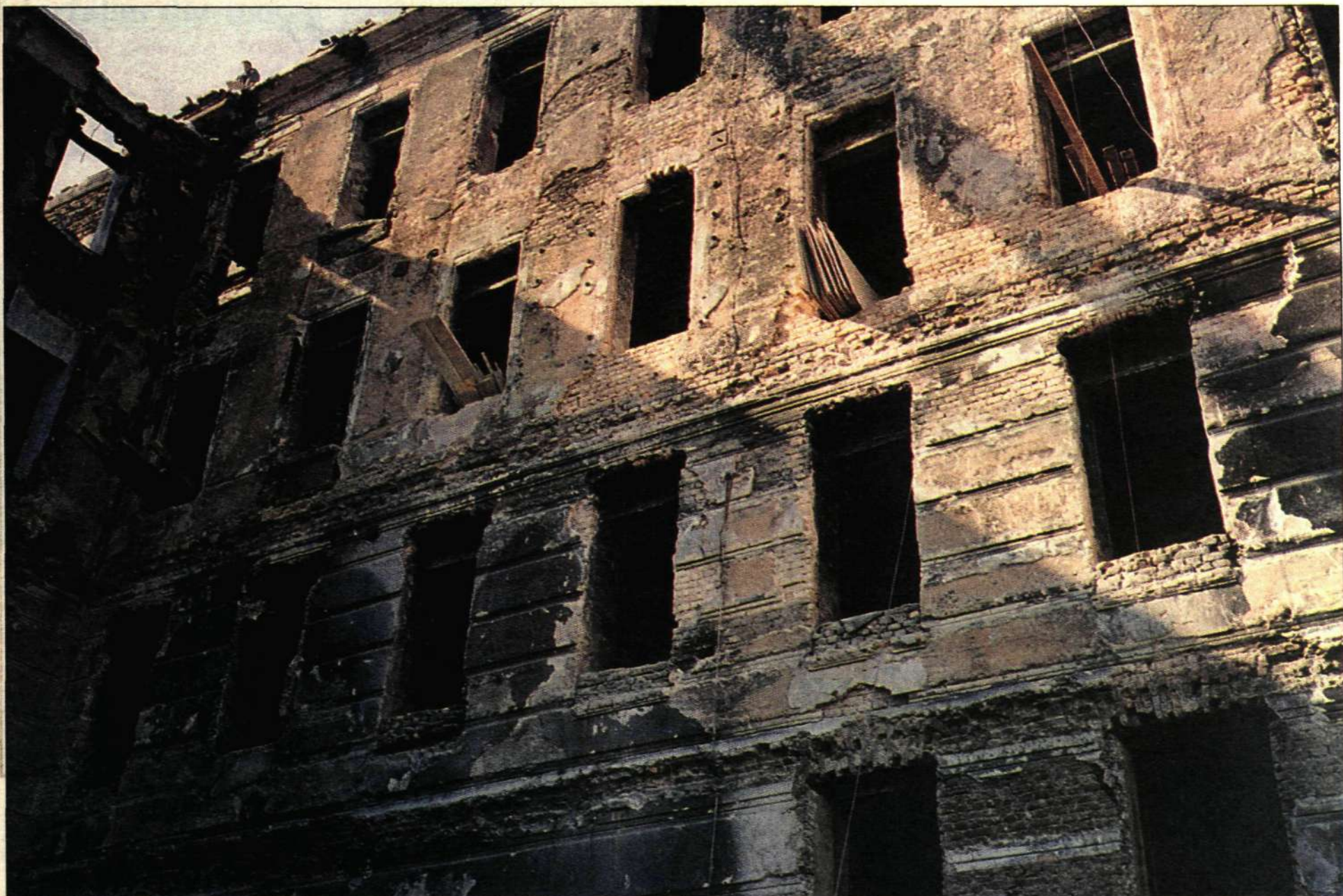
Ruin. Byggnaden där stationen ska installeras är det ärevördiga postkontoret i Sarajevo, invigt 1914 av kronprins Franz Ferdinand, strax innan han föll offer för det ödesdigra "Skottet i Sarajevo". Postkontoret var ett av de första husen som beskötts under kriget.
