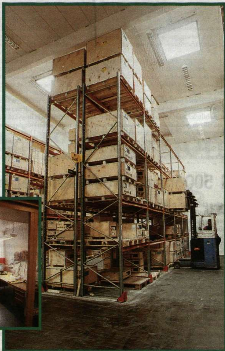
På distributionscentralen i Huddinge har man installerat elektroniskt styrda ljusschakt som släpper in dagsljus vilket ger bättre arbetsmiljö och sparar 70 procent av belysningskostnaderna.
