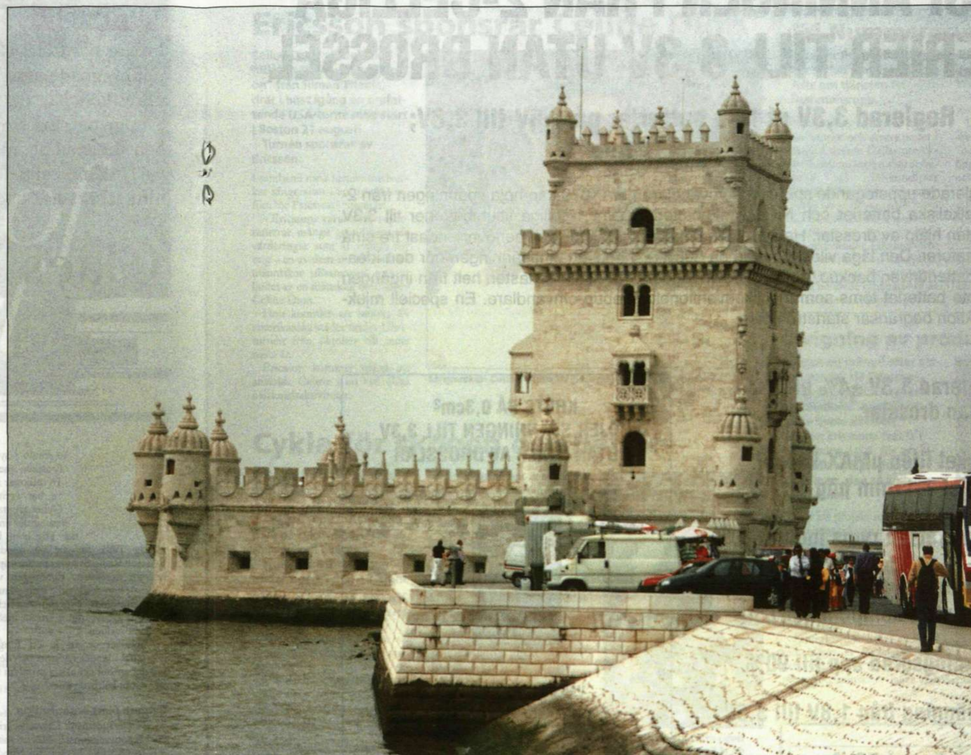
Torre de Belém vid floden Tejo är en mycket välkänd byggnad i Lissabon och ett "måste" för turisterna.
