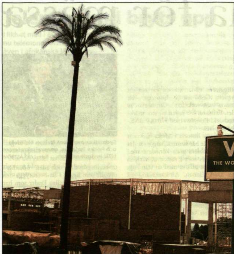
Finns det inga telemaster på plats får man ta vad som finns. Denna palm i Sydafrika är utrustad med både antenn och radiolänk. Foto: TORBJÖRN SELANDER
