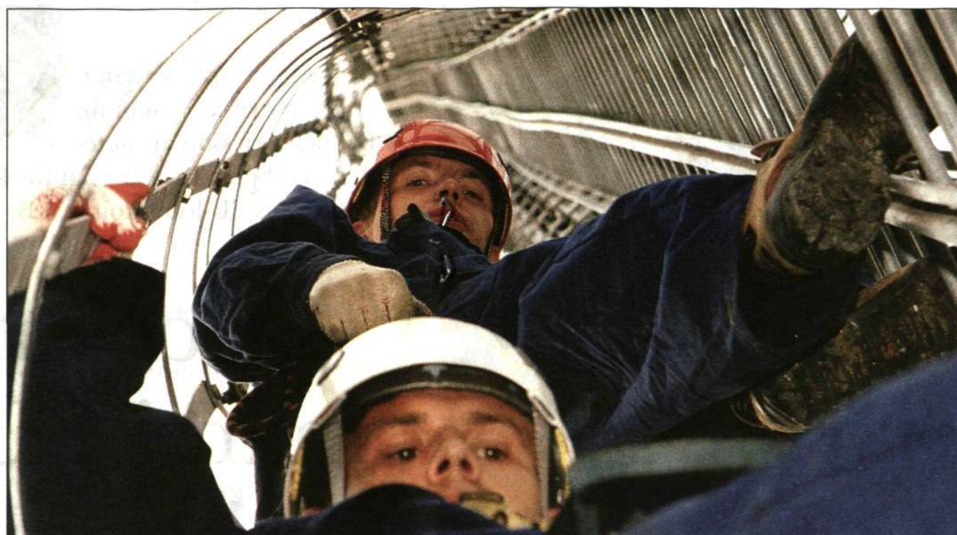
Pawel Pabiniak och Grzegorz Tomczyk jobbar på hög höjd med att installera radioantennor för GSM-nätet i Polen.
