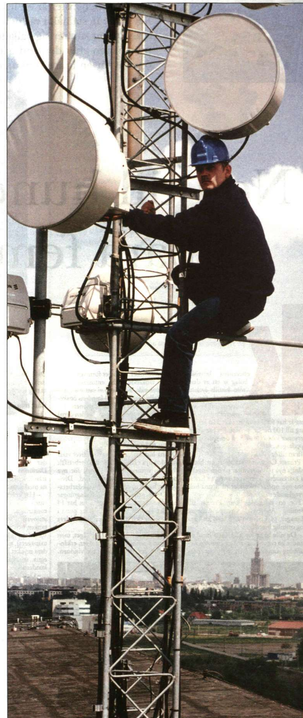
Transmissionsnätet är inte tillräckligt utbyggt i Polen, därför används radiolänkar flitigt när GSM-nätet byggs ut. På bilden Dariusz Drogosiewicz i en takmast med MINI-LINK.
