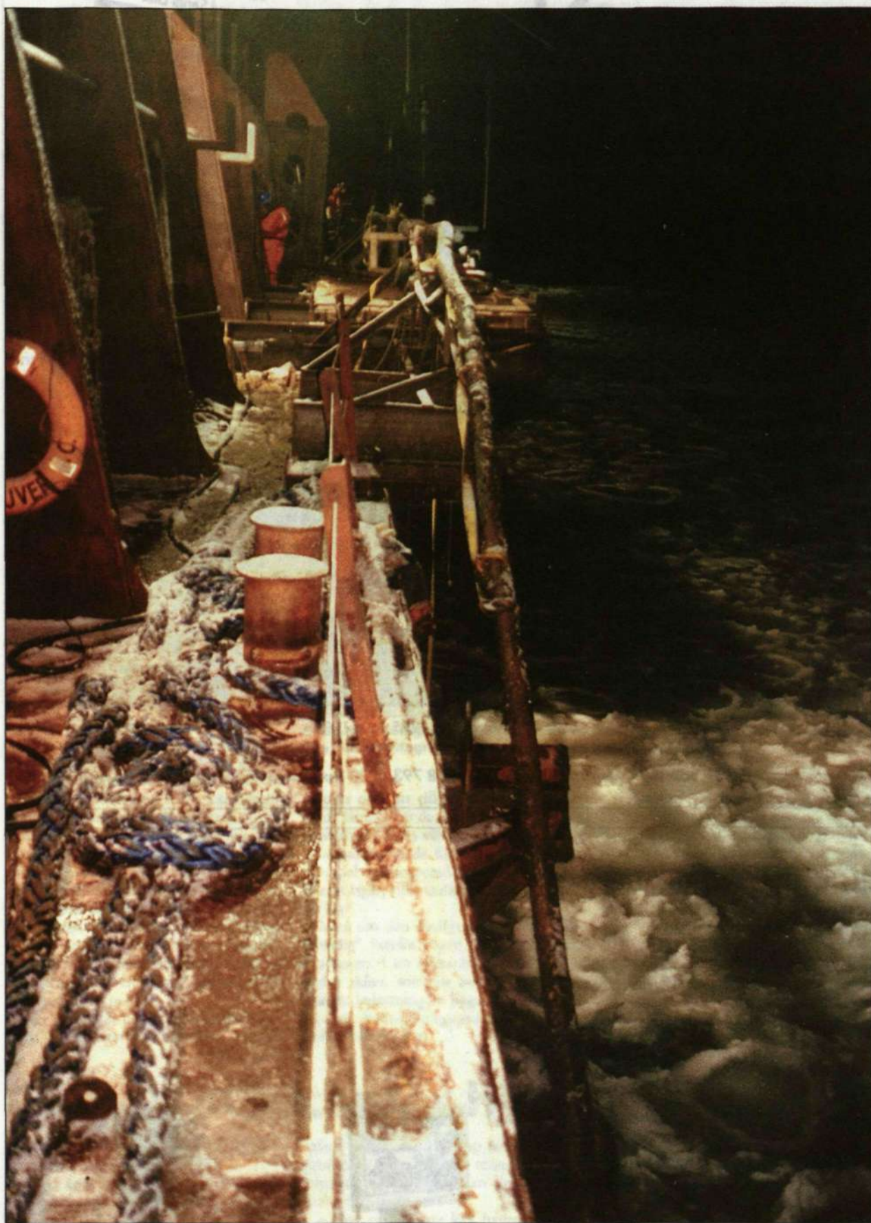
Packis, mörker, blåst och kyla – kabelreparationen i New Brunswick utfördes under sämsta tänkbara förhållanden.
