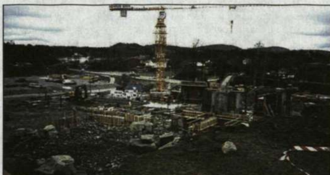
Ericsson i Norge bygger nytt i Grimstad i södra Norge. Redan från byggstadiet har en miljöprofilanalys gjorts vilket sparar både pengar och miljö.
