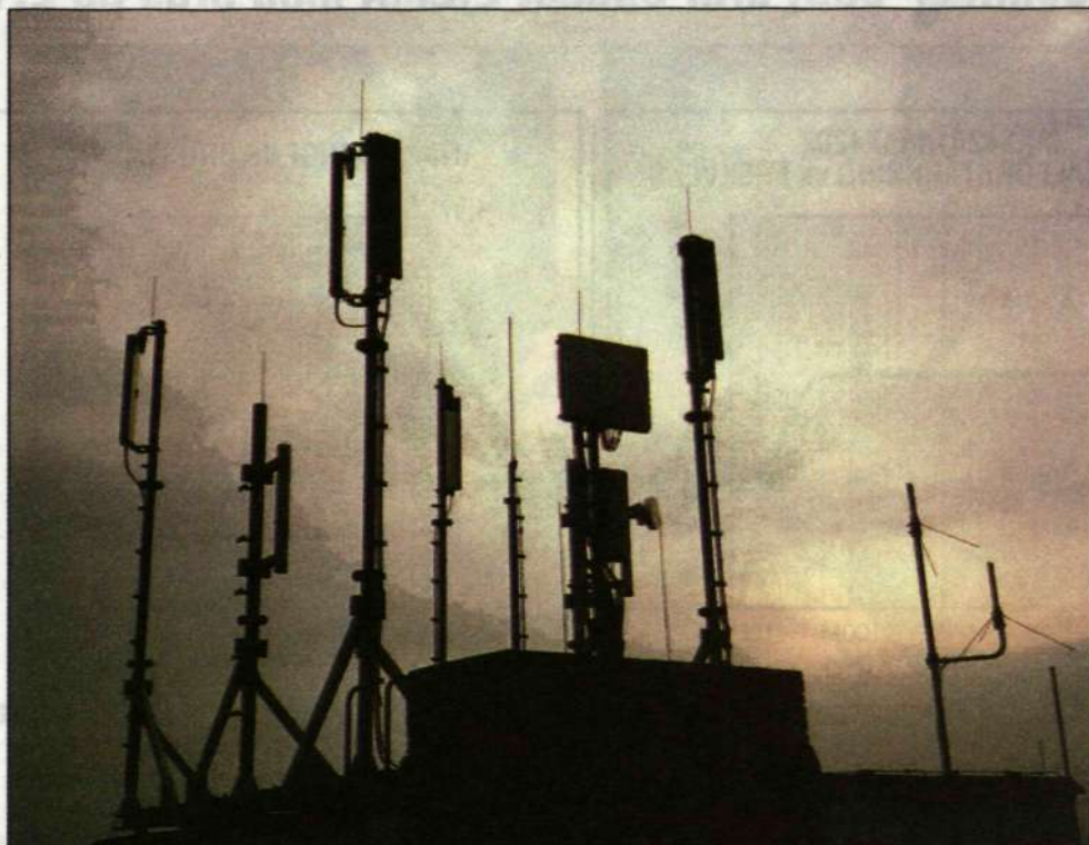
Ericssons teknik med adaptiva antenner (den breda i mitten) förbättrar både kapacitet och samtalskvalitet i GSM-nät. Ett försökssystem är nu i gång i ett kommersiellt nät i Tyskland.
