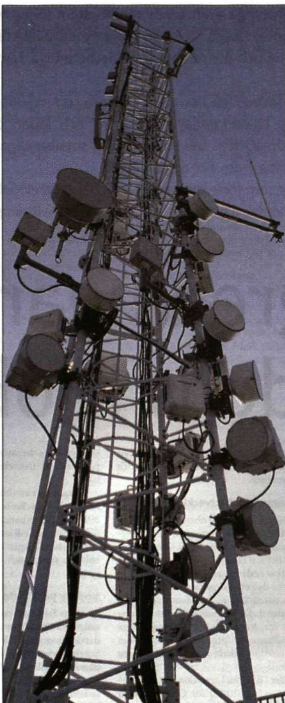
Det revolutionerande med MINI-LINK var att delar placerades utomhus, i direkt anslutning till antennen. Därigenom kunde en koaxialkabel kommunicera mellan modem och antenn.
