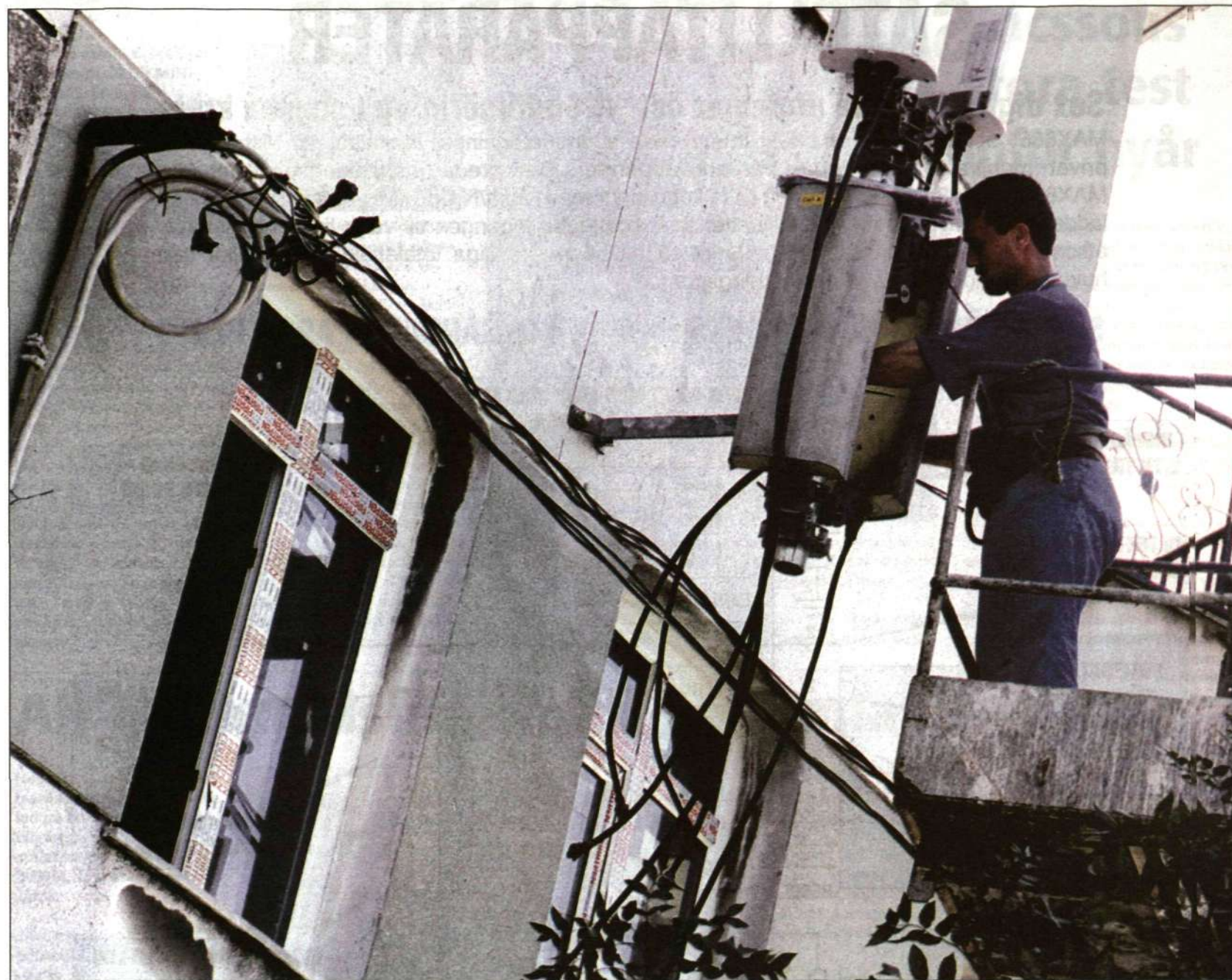
Ericsson genomför just nu en massiv installation av basstationer i Turkiet tack vare den stora ordern från Turkcell. Därför var det lätt att sätta in alla styrkor för att snabbt få igång kommunikationer i det drabbade området. Här monterar Mehmet Pigak en antenn till en basstation i stadsdelen Avcilar i utkanten av Istanbul. Foto: Lars Åström
