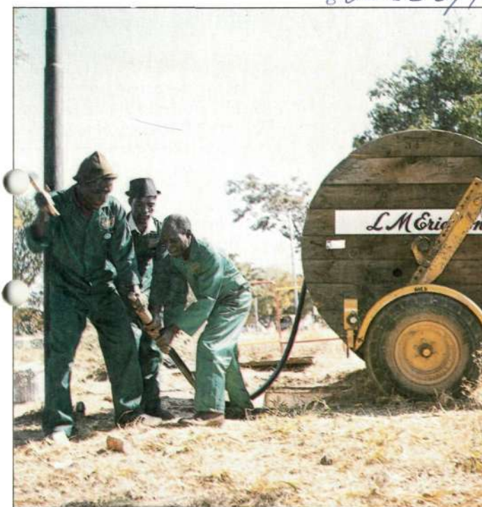
Kabelutläggning i Zambia utförd av inhemsk personal i LM Ericssons regi.
